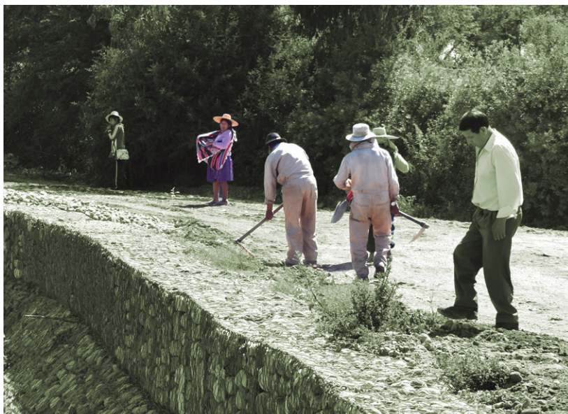
Protección de encauzamiento en Vinto - Río Rocha
